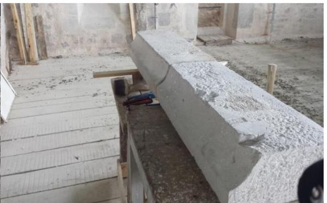
Taille de la partie manquante de la gargouille du mur Ouest, assemblage puis pose de l'ensemble
