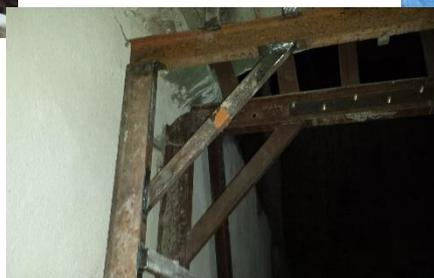
Mise en place de protection pour la fenêtre Est et ses enduits du 3<sup>ème</sup> étage
