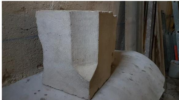
Taille d'un bloc de jambage pour la fenêtre sud du 3<sup>ème</sup> étage
