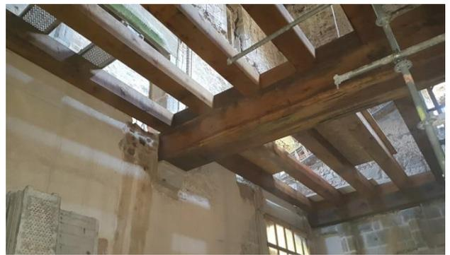
Le quatrième étage a été utilisé comme espace d'approvisionnement et de stockage. Un treuil capable de recevoir jusqu'à 150 kg a été aménagé sur rail permettant de faire entrer les matériaux acheminés. Une bétonnière en kit a été montée et installée, un silo à sable a été installé, des futs ont été utilisés comme citernes à eau et des zones de stockage des gravats délimitées. Une trappe de communication entre le quatrième et le troisième étage, équipée d'une goulotte a été installée.
