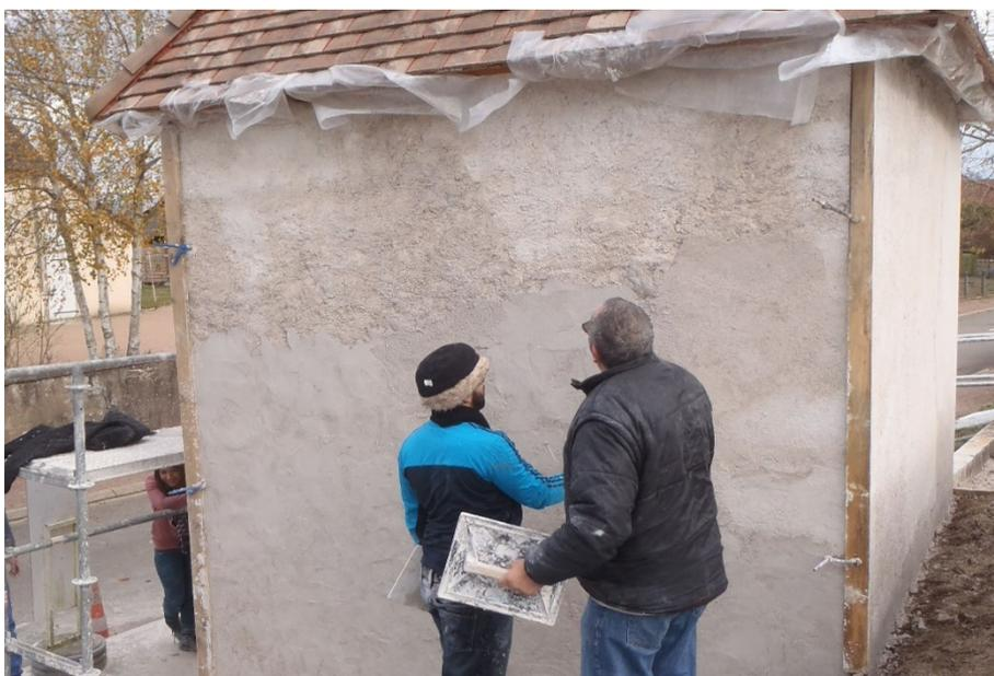
Après le temps de séchage nécessaire nous posons des règles sur les quatre angles du pigeonnier à l'aide de crosettes, également appelées chevillettes, qui nous serviront par la suite pour déterminer l'épaisseur de l'enduit de finition.
