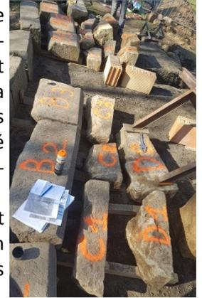
Après avoir fouillé les contours de la voûte, nous mesurons l'écartement situé au niveau des joints des pierres taillées pour pouvoir élaborer un plan d'action pour le repositionnement. A cette occasion, nous nous apercevons que l'un des blocs soutenant la voûte a été fortement altéré.
