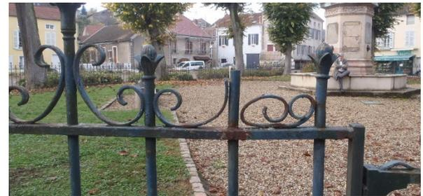
Comme vous pouvez le voir sur les photos au-dessus, des têtes de 2 modèles différents en fonte sont manquantes, des volutes en mauvais état, des barreaux tordus ou cassés et l'ensemble des grilles doit être redressé et réaligné suite à l'affaissement des pierres causé par les racines des arbres. Il y a également 5 portails dont 1 manquant qui doit être entièrement fabriqué.
