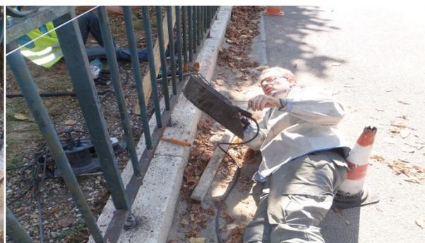
Nos grilles correctement alignées et d'aplomb, nous effectuons nos scellements. Pour cela nous utilisons un tube en cuivre pour souffler l'intérieur des trous que nous remplissons ensuite avec le produit de scellement chimique suivi d'un lissage à la spatule.
