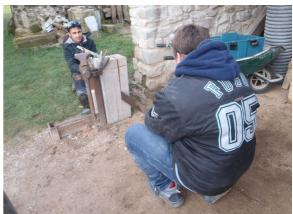
En attendant l'arrivée de la grue, il nous a fallu tronçonner, à une extrémité, la poutre maîtresse à 8.30m pour permettre son installation dans ses trous d'ancrage.
