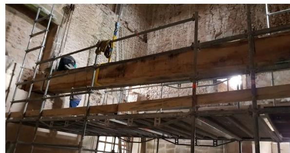
Nous avons récupéré des I.P.N pour fabriquer un portique qui nous permettra de monter les solives au 3ème étage. Cet IPN recevra notre treuil électrique qui pourra coulisser de l'extérieur vers l'intérieur. Pour cela il nous a fallu faire des découpes et des soudures pour pouvoir l'assembler et le mettre en place pour nous permettre de continuer dans l'avancée de nos travaux. Les compétences d'Oliver en métallerie sont utilisées, il s'est chargé presque intégralement de cette tâche.
