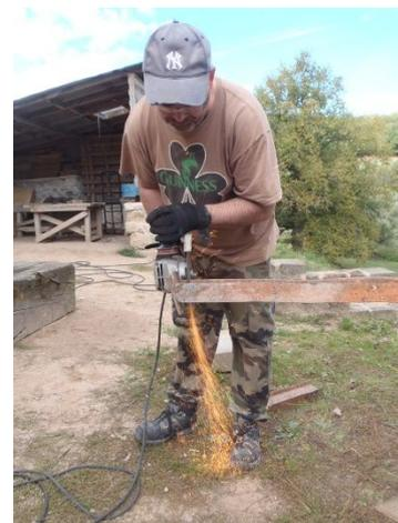
A l'aide de nos deux anciens tubes de construction métallique, Olivier et Gauthier ont réalisé deux consoles en applique. Après un carottage effectué par Laurent, Seb et Denis, les deux tubes (consoles) ont été fixés pour soutenir l'échafaudage en encorbellement de la fenêtre bien délabrée du 3ème étage du mur est.
