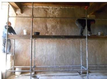
Les enduits sont composés d'un mélange de sable, d'eau et de chaux naturelle et doivent être appliqués en trois couches : tout d'abord sous la forme d'un gobetis suivi d'un corps d'enduit pour arriver enfin à notre couche de finition. Nous devons maintenir notre rythme pour arriver au stade de l'enduit de finition avant la mi-avril.
