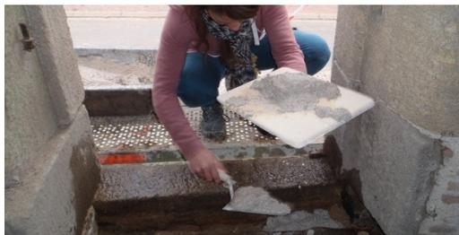
Une fois sec, nous pouvons passer à l'application de l'enduit coloré ocre. Des règles sont placées aux angles de l'édifice pour nous permettre de faire les arrêtes bien droites. Elles nous servent de guides pour l'application de l'enduit final.
