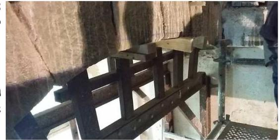
Suite au déplacement général des éléments de la voûte, la façade doit être réalignée. Noël se porte volontaire pour cette tâche, il doit retailer les blocs de pierres et les layer. Pendant ce temps, nous pouvons retirer définitivement la structure métallique.
