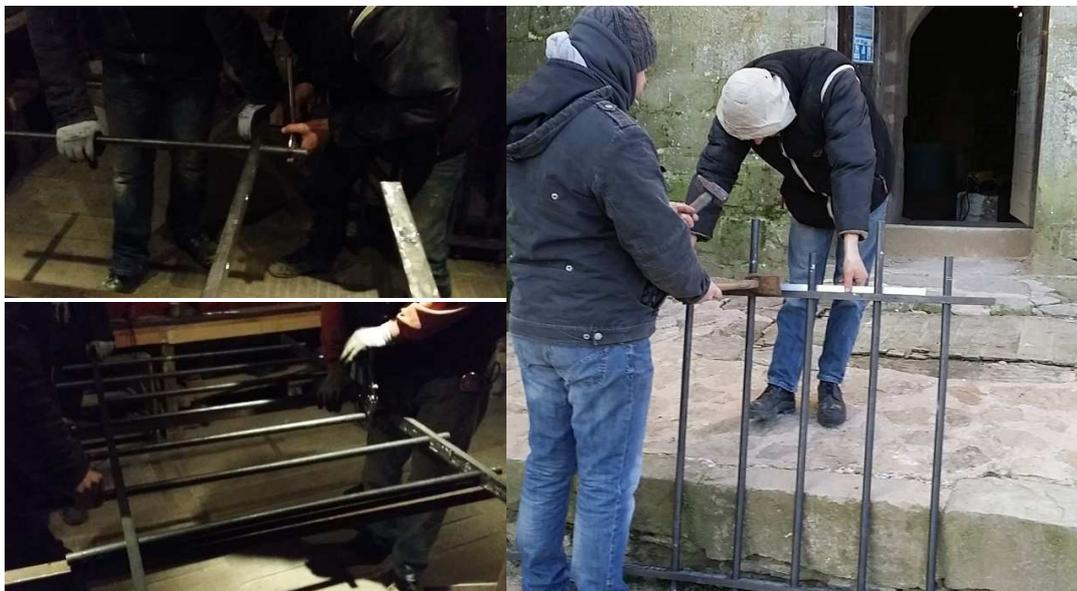
Un gond et un pivot sont soudés sur les montants extérieurs des vantaux. Nous devons également en souder sur les grilles déjà en place à Rully. En se référant à ceux d'origines, des goussets d'angles sont créés à l'identique. Ils servent à renforcer les angles des vantaux.
