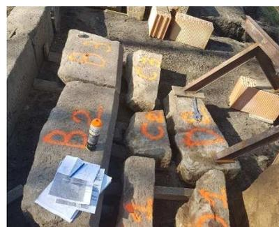
Après avoir fouillé les contours de la voûte, nous mesurons les traces d'écartement situées au niveau des joints des pierres taillées pour pouvoir élaborer un plan d'action pour le repositionnement car nous nous apercevons que l'un des blocs soutenant la voûte a été fortement altéré.
