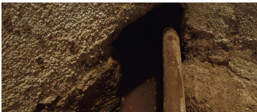
Frédéric et Renaud ont continué le débouchage de l'évacuation du sous-sol de la tour avec un furet monté sur un nettoyeur haute pression. Nous le passons dans un tube en pvc de diamètre 80 mm pour éviter qu'il s'enroule sur lui-même. Les 12 mètres du furet ne sont malheureusement pas suffisants.
