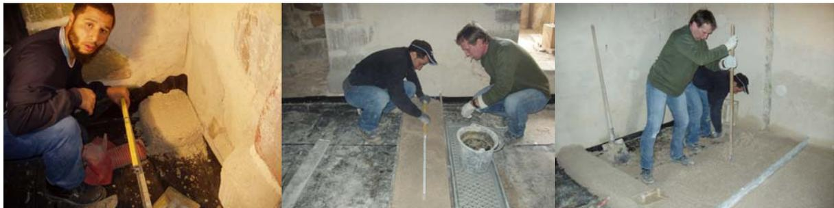
Toute la chaux est montée par treuil dans des seaux, Gauthier le ferronnier nous a aidé à installer tout le montant pour la mise en place du treuil et à placer des élingues de renfort pour que l'IPN ne vrille pas.
