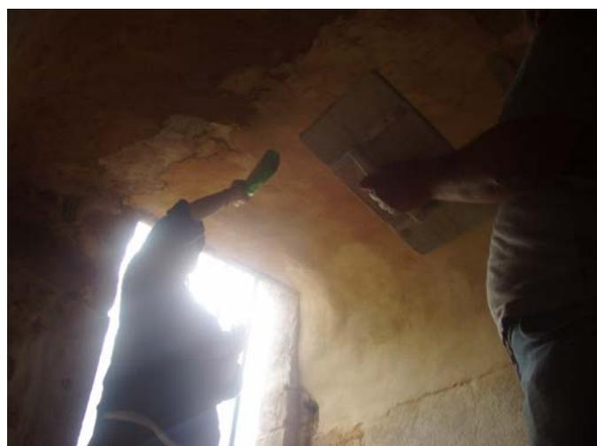
Hadj a fini la petite pièce de l'étage en enduisant un mur et en posant les tomettes manquantes. Le reste de l'équipe était séparé en deux groupes : un groupe qui travaillait sur les enduits et l'autre, polyvalent, alternait entre le désherbage des abords de la tour et le tamisage pour faciliter le travail des enduits. Nous avons aussi réparé, pour les visiteurs, une marche en bois de la montée d'escalier extérieur menant à la tour .
