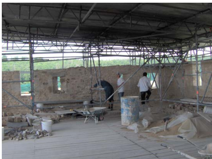
Piquetage des murs
