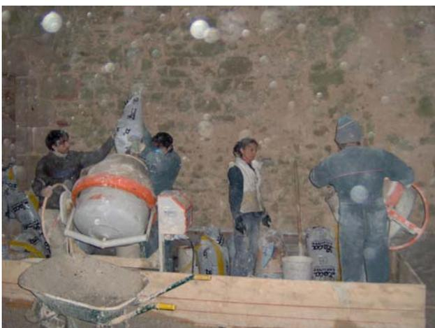
Etendre cette composition sur 70 m<sup>2</sup>... Vaste programme... Réglage au niveau sur la grande règle et au râteau pour égaliser.... Pour assurer l'approvisionnement nous avons monté quelque 300 sacs de billes d'argile et des sacs de chaux à la chaîne et parfois seul...
