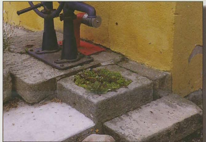
observer : elle est presque totalement enterrée sous le tuyau de la pompe dont elle servait jadis à l'écoulement et l'évacuation de l'eau. Elle est munie de deux tiges de fer transversales, ancrées dans les côtés de la cuve, sorte de grille qui servait de support pour les seaux lors de leur remplissage. En outre, remplie de terre, elle sert de bac à fleurs.
