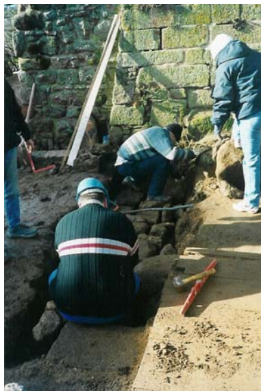
Consolidation des fondations
