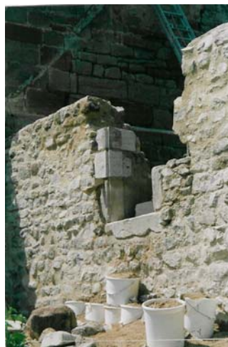
Pose des nouveaux jambages
