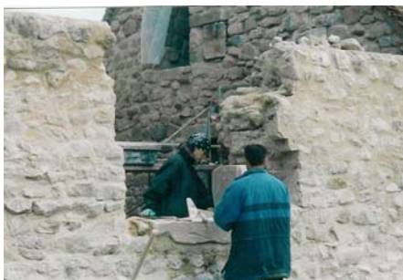
Démontage de la fenêtre
