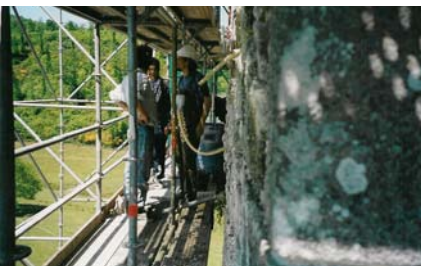
Maçonnerie de la partie sommitale
