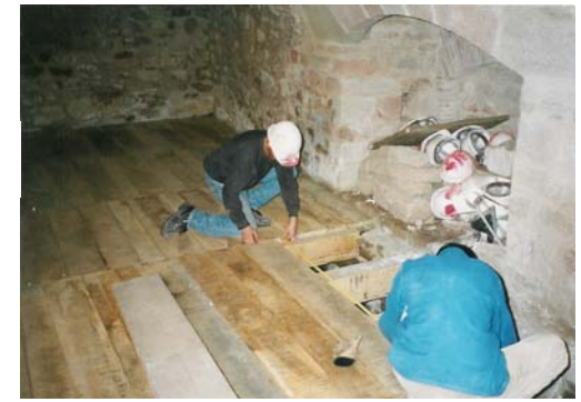
Pose du plancher
