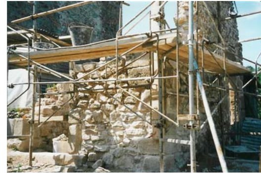
Maçonnerie de la grange
