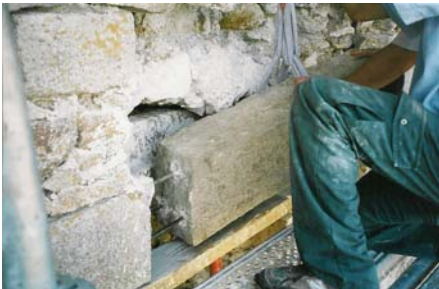
Scellement du linteau
