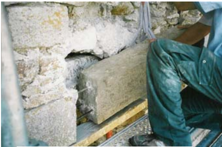
Scellement du linteau
