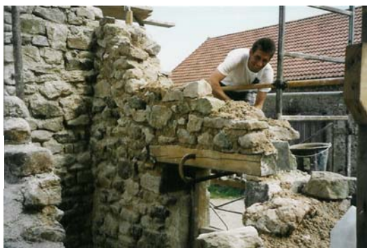
Maçonnerie de la grange
