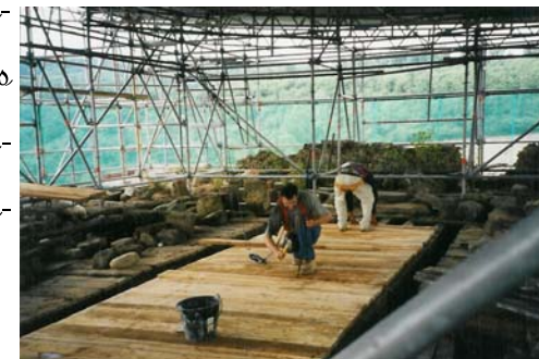
Pose du plancher
