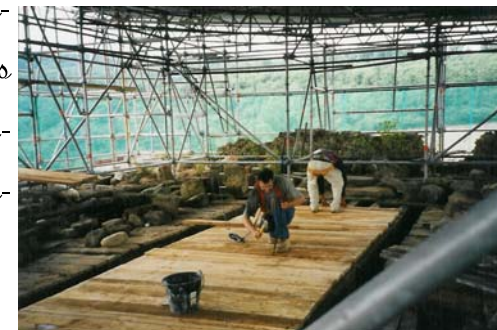
Pose du plancher
