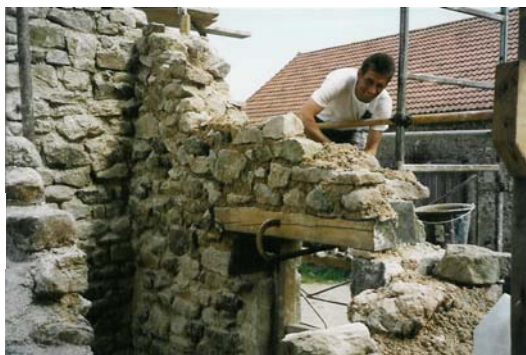
Maçonnerie de la grange
