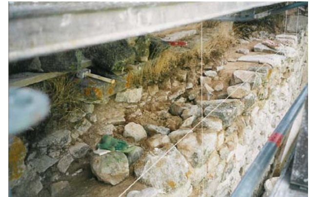
Arrase des murs au sommet
