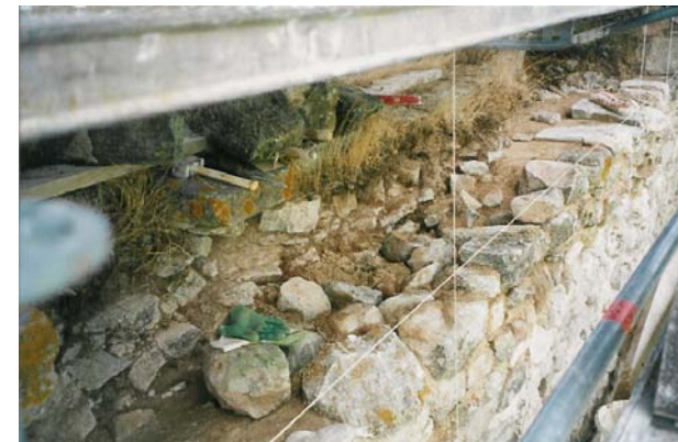
Arrase des murs au sommet
