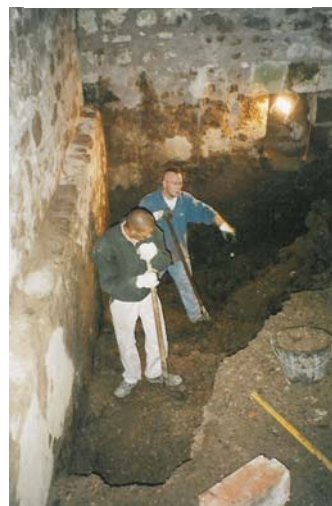
Décaissement de la cave
