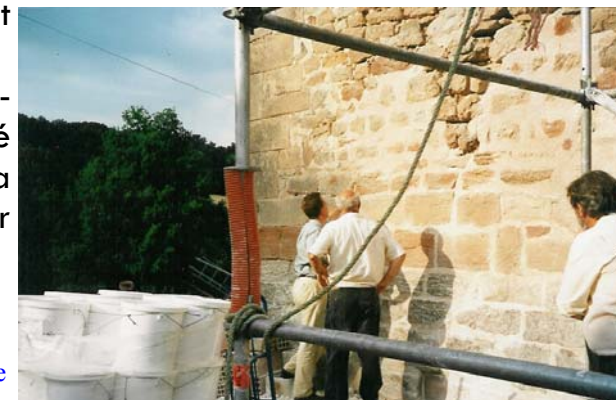
Visite de l'architecte
