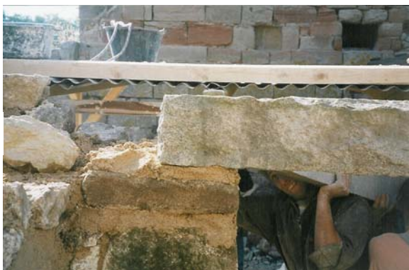
Pose d'un linteau
