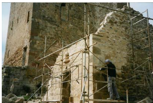
Jointoyage d'un linteau
