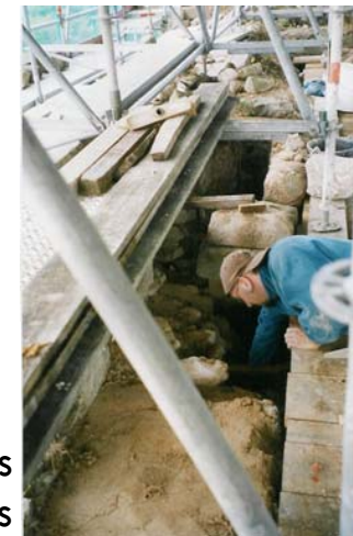
Consolidation des murs intérieurs
